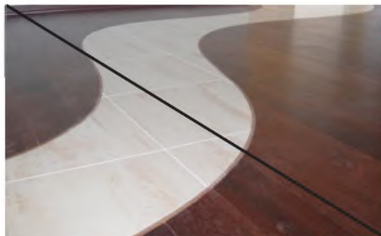
Плохо Узорные стыки из разных материалов
